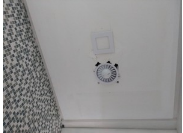
FIGURA 4 – Trecho quebrado no forro de gesso do Lavabo, justamente onde deveriam ser fixados os parafusos da tampa do exaustor.
