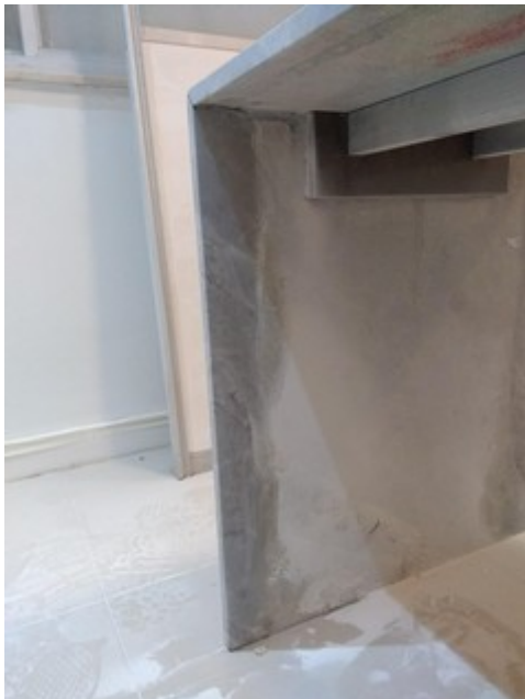
FIGURA 13 – A outra extremidade interna da bancada de arabescato da Recepção, já polida.
