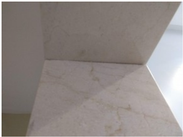
FIGURA 3 – Encontro entre peças mostrando a irregularidade dos cortes.
