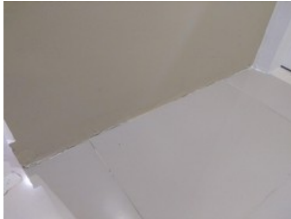
FIGURA 11 – Rejuntar canto da parede com rejunte na cor Palha (para Anderson)
