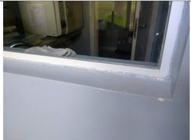
FIGURA 8 – Retocar cantos das janelas fixas (ADM e Esterilização) onde há silicone (a aderência da tinta nesses locais é ruim... talvez seja necessário remover o excesso de silicone nesses pontos).
