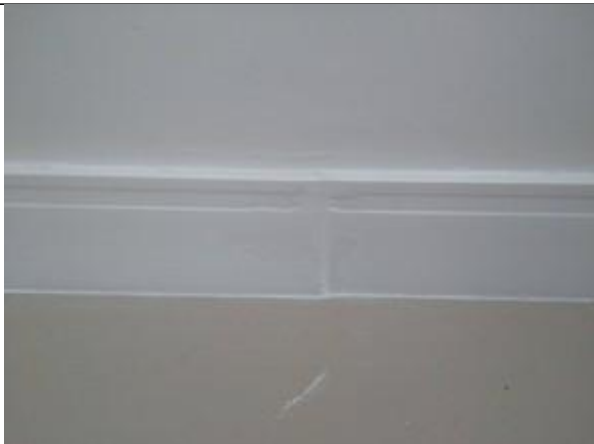
FIGURA 3 – Os rodapés ainda ficaram com alguns pontos que mereciam acabamento mais fino, como nas emendas das peças, por exemplo (Foto: Sala dos Funcionários).
