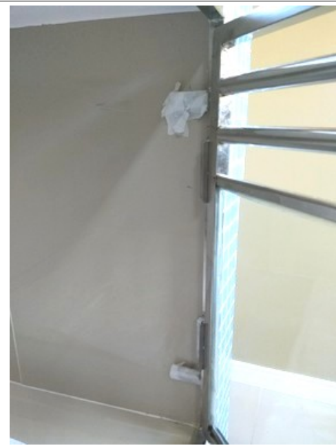
FIGURA 8 – Lixar todas as dobradiças das portas dos gatis para aparar as arestas perfurantes.
